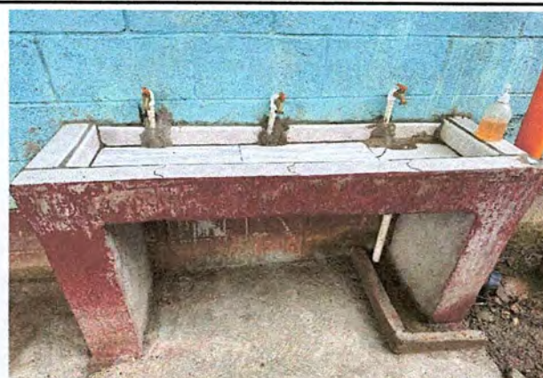
Foto 4: Mejoramiento e instalación de lavado de manos
