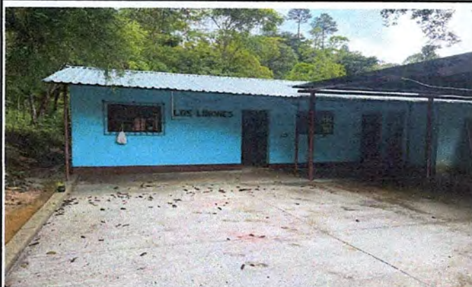
Foto 3: Mejoramiento instalación cambio de techo.
