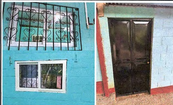
Foto 1: Mejoramiento instalación de puerta metalica y ventanas pvc.
