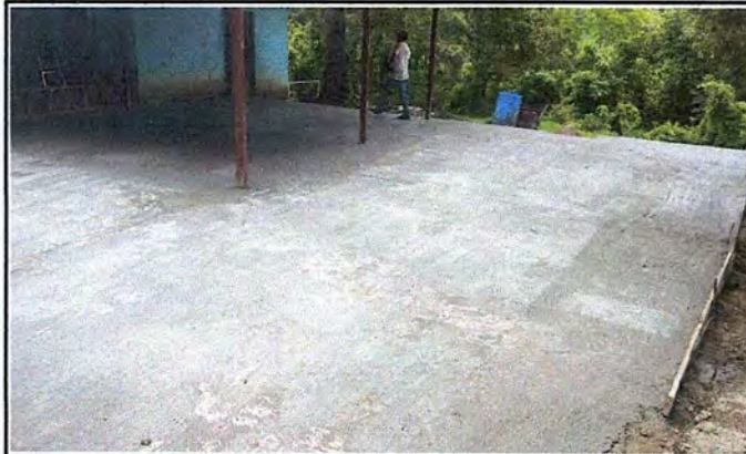
Foto 2: Mejoramiento instalación piso torta cemento.
